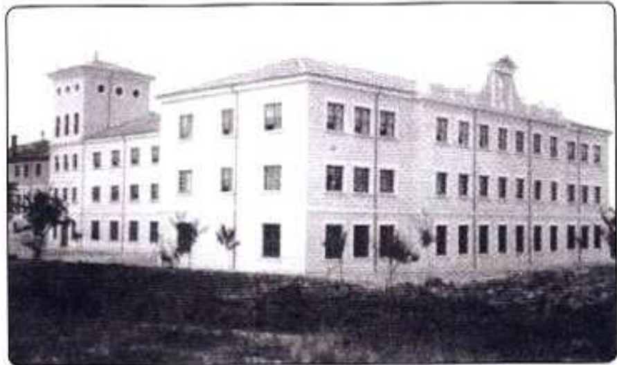
LOS NUEVOS EDIFICIOS ADOSADOS AL ANTIGUO SEMINARIO
